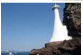
黒島の西端にある、小さな白亜の燈台。
